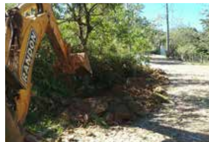
Alargamento de pista na Alameda Flores
